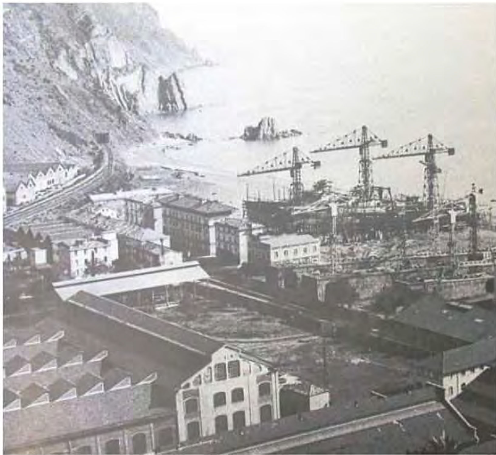
Il cantiere di Riva Trigoso ai primi del Novecento, quando cominciava a diventare più grande del paese
