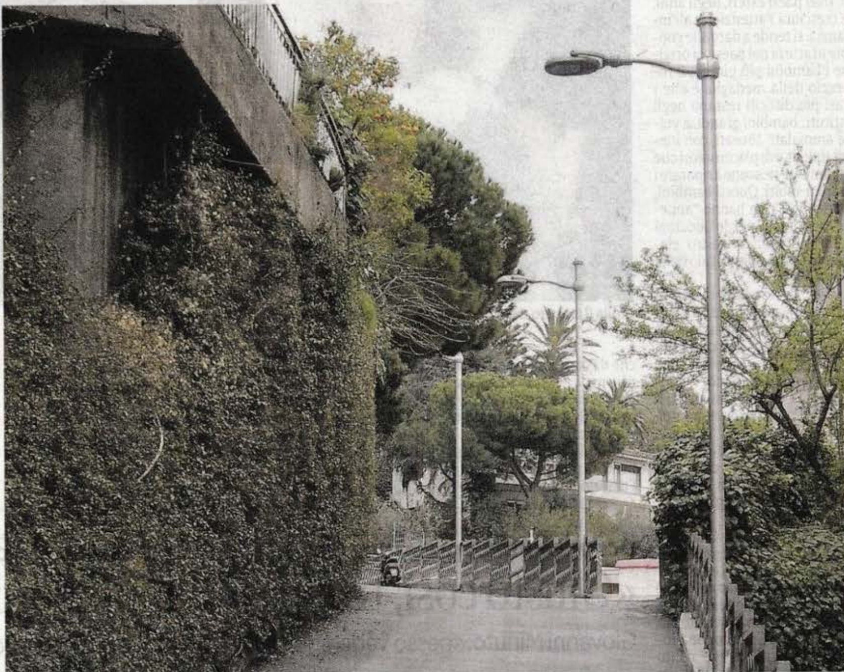
Pali della pubblica illuminazione: per la lampada rotta sulla provinciale del Facciù sono già stati inoltrati diversi solleciti
