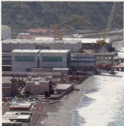
Il cantiere di Riva oggi
