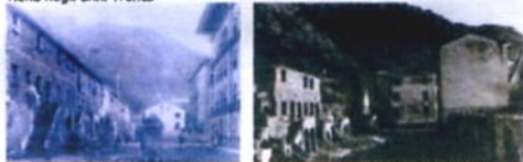
La "casa rossa" negli anni Venti e, a destra, dopo i bombardamenti del 1944
